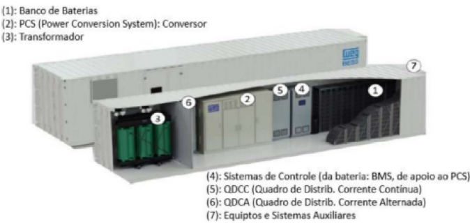
Figura 38 – Componentes de BESS no interior de um Eletrocentro (WEG, 2023).
