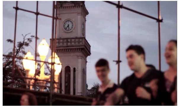
Figura 39: Torre da estação ferroviária.
