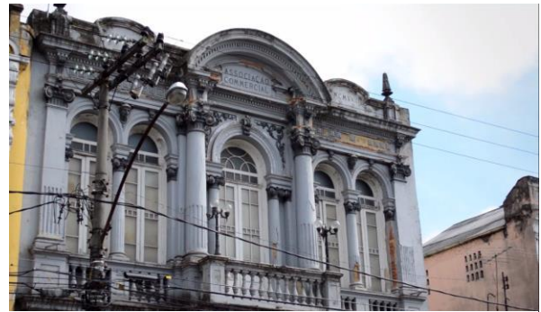
Figura 41: Edifício da Associação Comercial.
