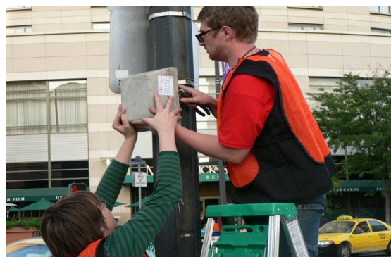
Figura 10: Montagem da estrutura.
