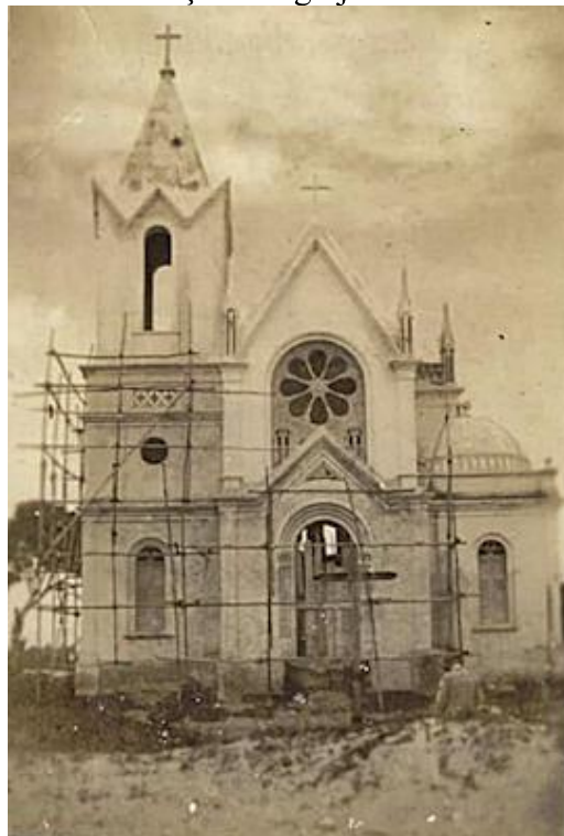
FIGURA 10 – Construção da Igreja de São Boaventura (BA)
