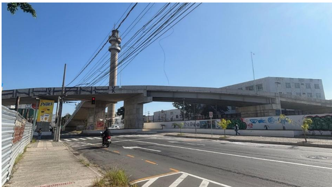
Figura 41 - Viaduto Roza Cabinda.
