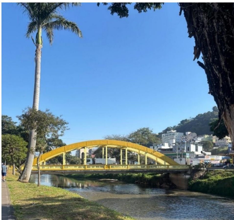
Figura 44 - Ponte Carlos Otto.
