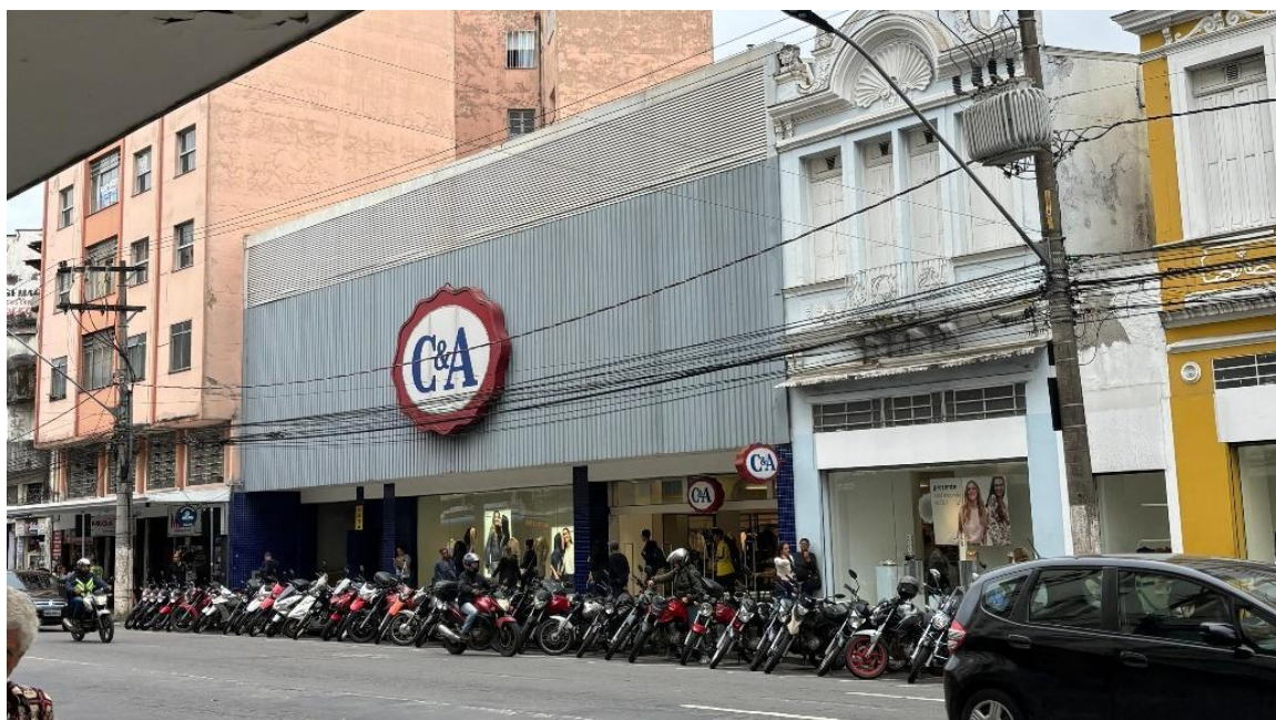
Figura 24 - Fachada da C&A, na Av. Pres. Getúlio Vargas.
