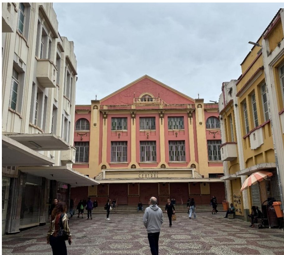
Figura 17 - Fachada do Cine-Theatro Central.
