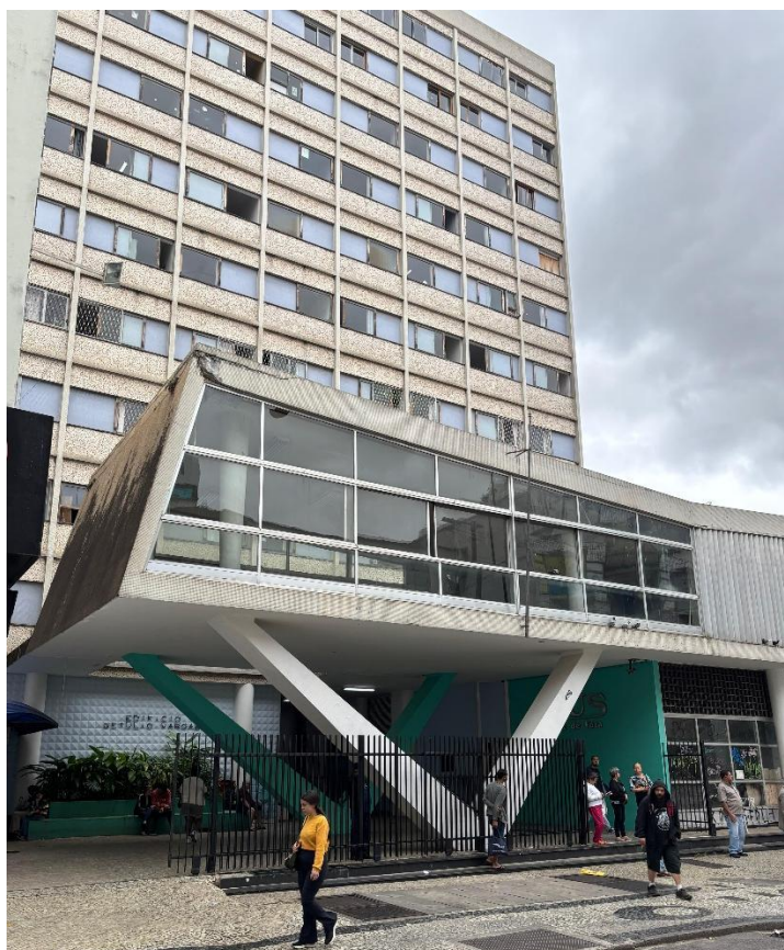
Figura 16 - Edifício Getúlio Vargas.
