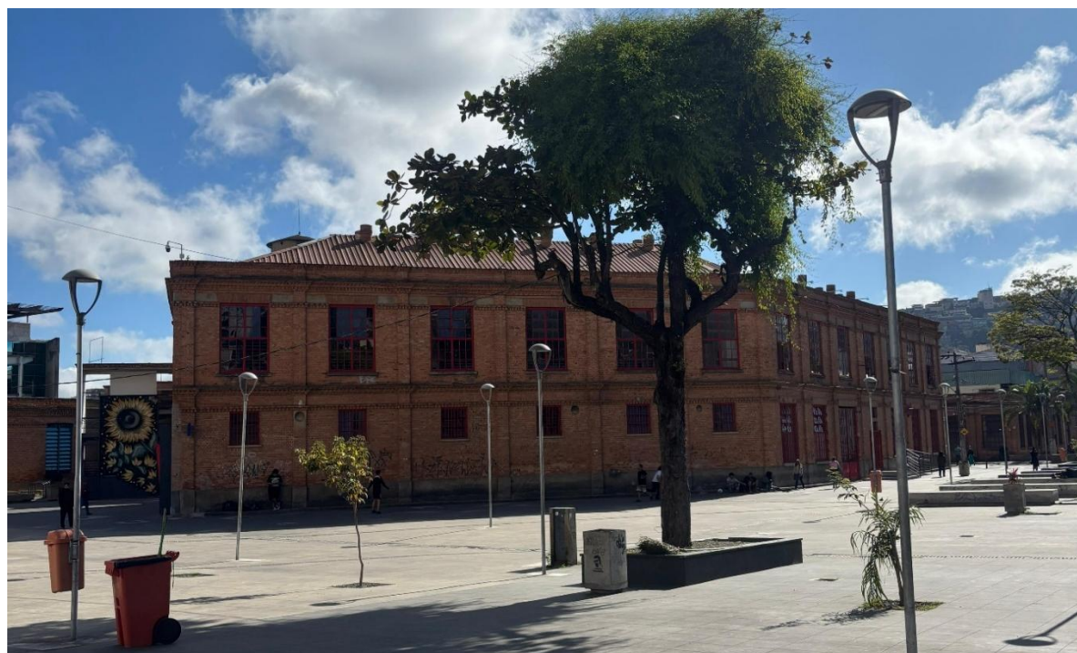
Figura 28 - Fachada do Mercado Municipal de Juiz de Fora.
