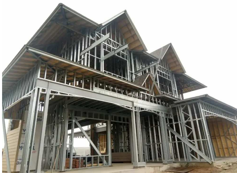
Figura 3.2 – Exemplo de edificação em construção utilizando o sistema LSF, evidenciando a estrutura metálica formada por perfis de aço galvanizado. [Decorações, n.d.]
