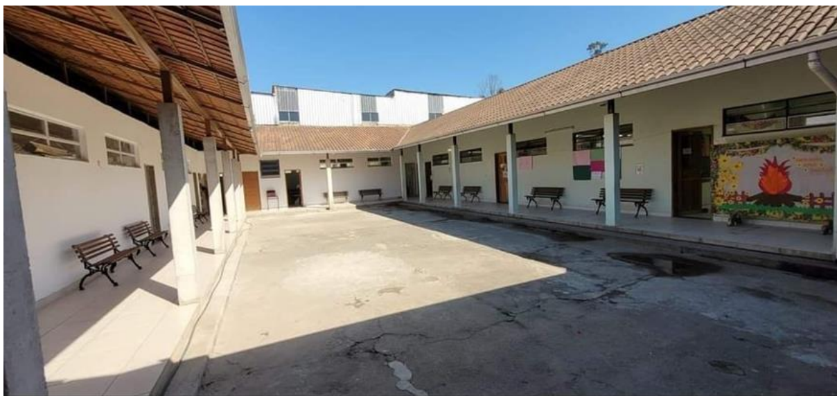
Figura 2 - Vista interna da Escola Estadual Ana Salles
