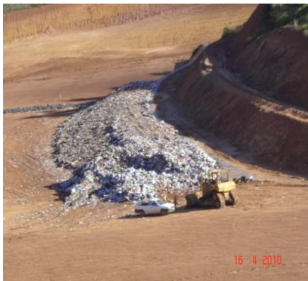
Figura 26 – Compactação dos resíduos. Fonte: DEMLURB, 2012.
