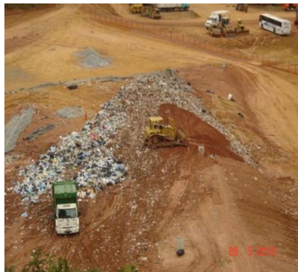
Figura 27 – Cobertura dos resíduos. Fonte: DEMLURB, 2012.
