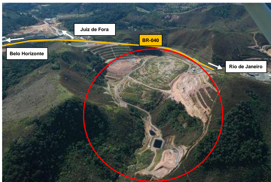
Figura 24 – Foto aérea com croqui de localização do Aterro Sanitário de Juiz de Fora – vertente direita do sítio Salvaterra (Jun. 2006). Fonte: Adaptado de DEMLURB, 2012.
