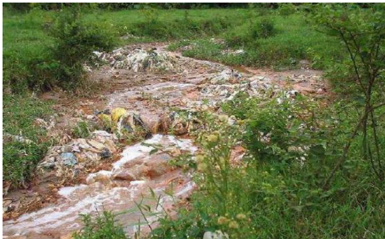
Figura 23 – Maciço de lixo deslizado do aterro controlado/lixão e resultante poluição do Córrego Salvaterra em janeiro de 2005. Fonte: DEMLURB apud VALE, 2006.
