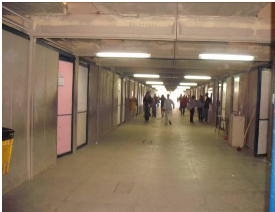
Imagem1: Prédio anexo ao Colégio Estadual Sol Nascente “Lelezinho”
