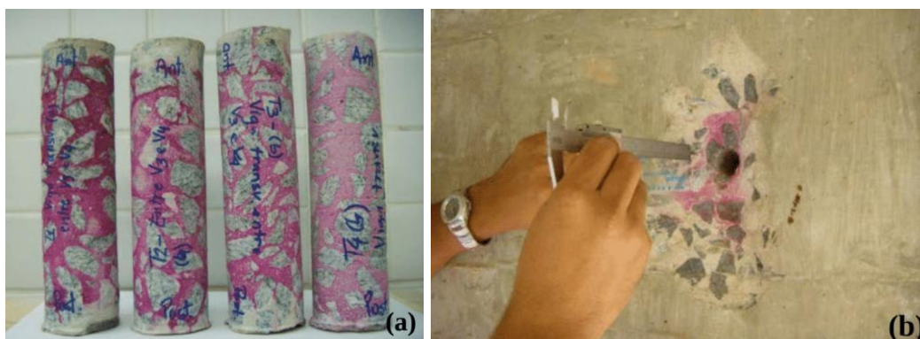
Figura 19 – Medidas de carbonatação em testemunhos, corpos de prova (a) e estruturas reais in loco (b), com soluções de fenolftaleína.
