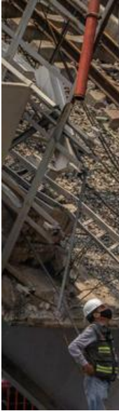
(b) Colapso de Ponte em 2021 [9]
