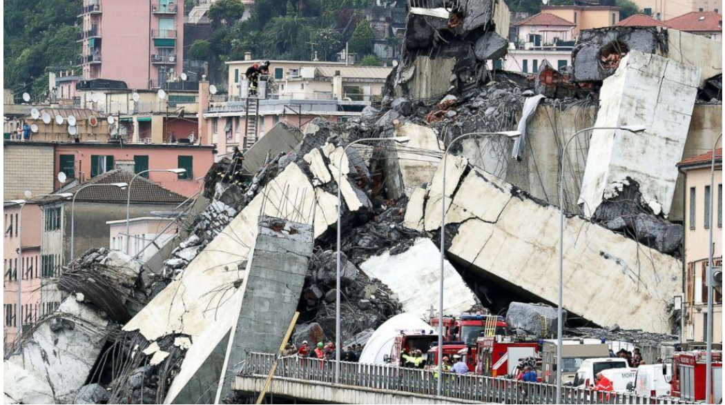
(a) Colapso de Viaduto em Gênova, 2018 [9]
