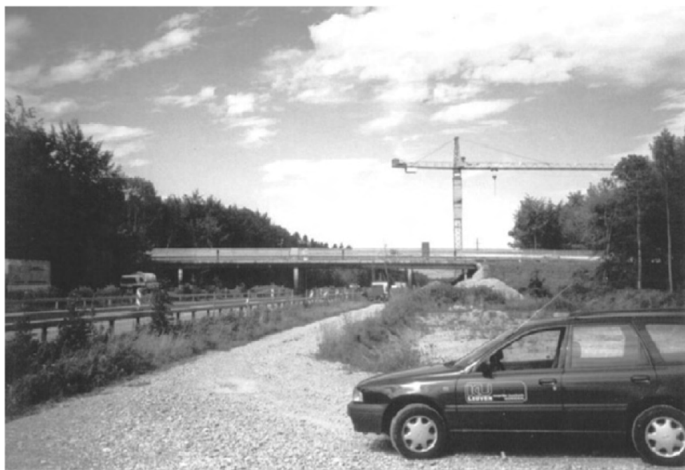
(a) Vista da Ponte Z24
