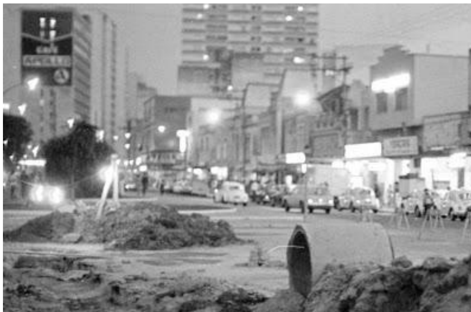
Figura 8 - Construção do Mergulhão
