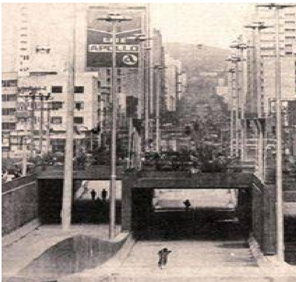
Figura 10 - Vista do Mergulhão construído
