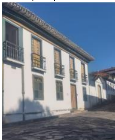
Figura 1 - Fachada principal da Casa da Chica da Silva
