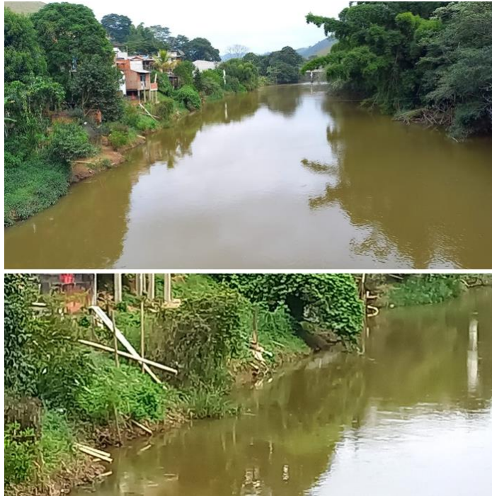
Figura 16 - Rio do Peixe e canalização para o lançamento de esgoto bruto.
