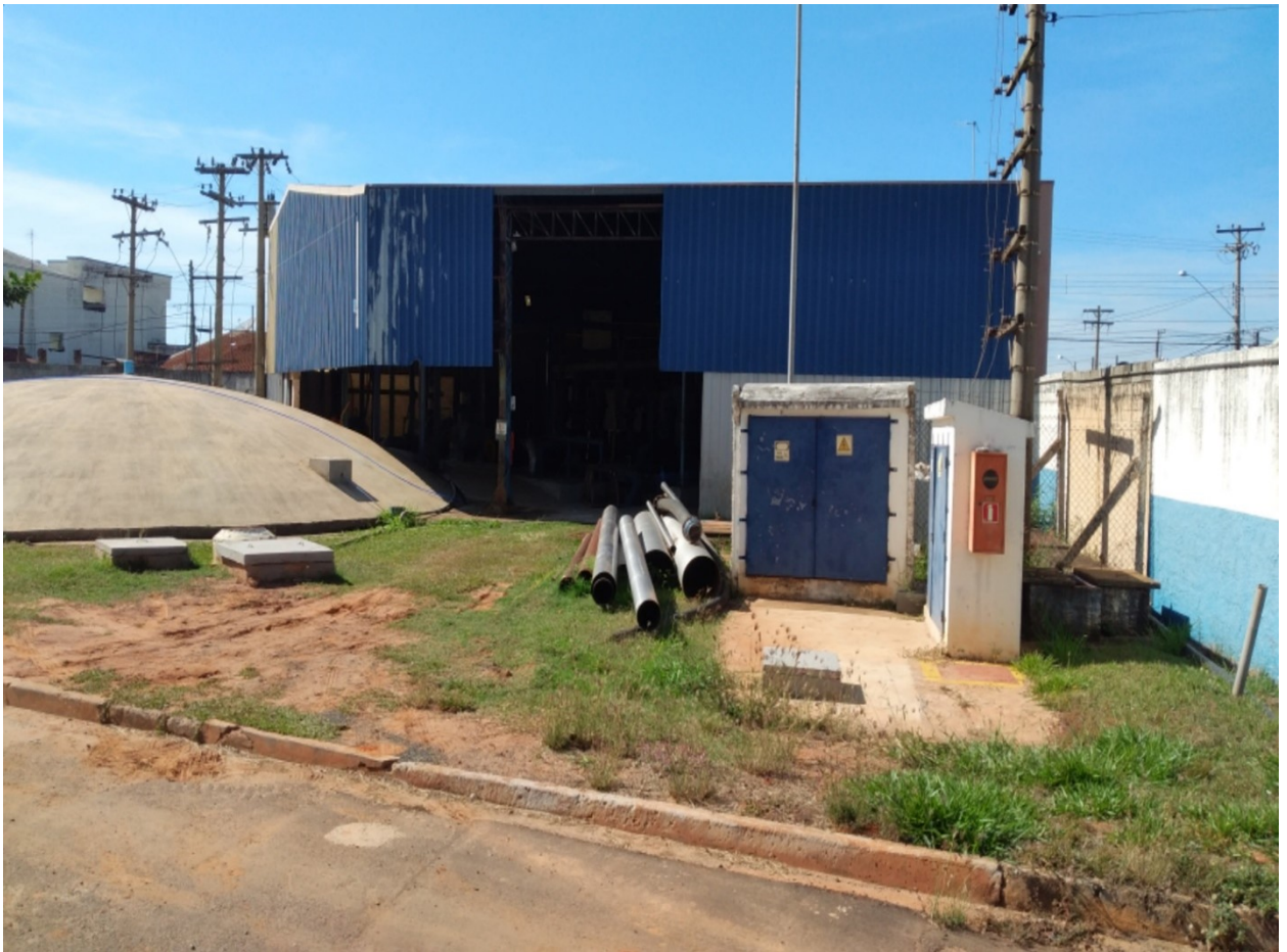
Figura 6 – Casa de máquinas ETA I
