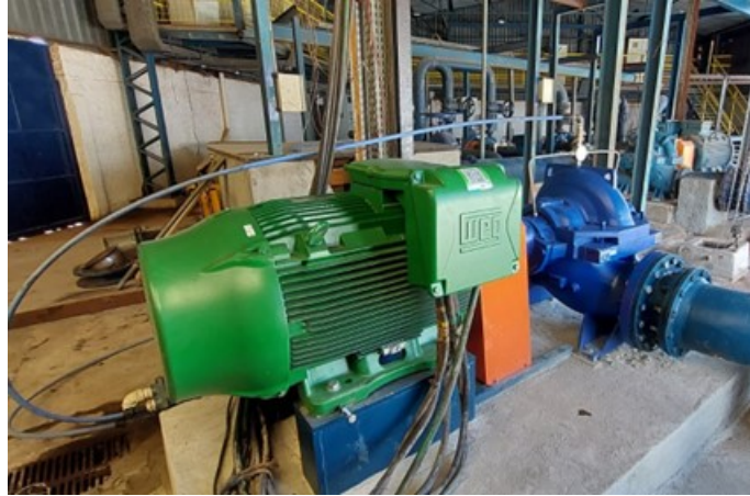
Figura 25 – Conjunto proposto instalado - ETA I
