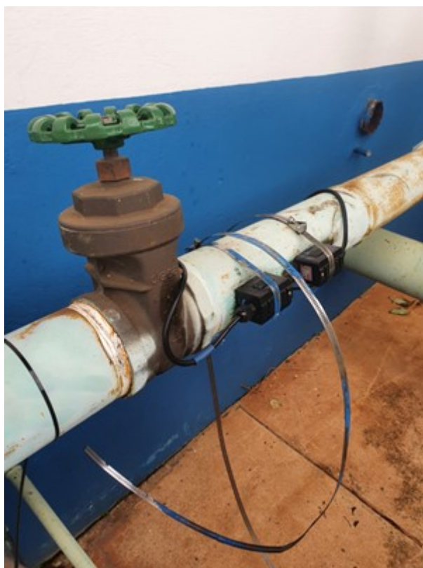
Figura 33 – Metodologia de medição de vazão período de determinação - ETA II
