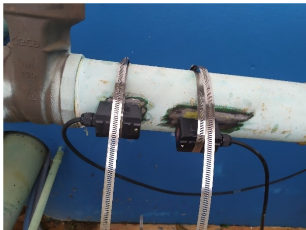
Figura 31 – Metodologia de medição de vazão período linha de base - ETA II
