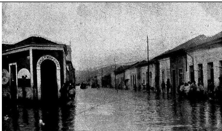
Enchente de 1919 - Rua 15 de Novembro atual Avenida Presidente Getúlio Vargas, esquina com a Rua do Comercio atual Rua Batista de Oliveira.
