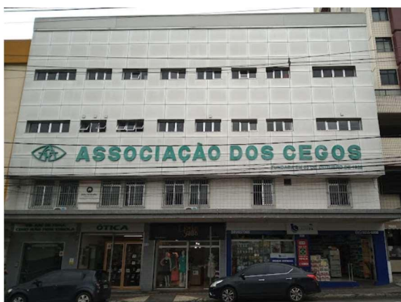
Figura 4 – Fachada Associação dos Cegos 2024.
