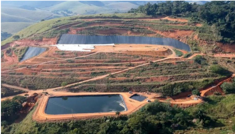
Figura 4 - Aterro sanitário de Muriaé-MG
