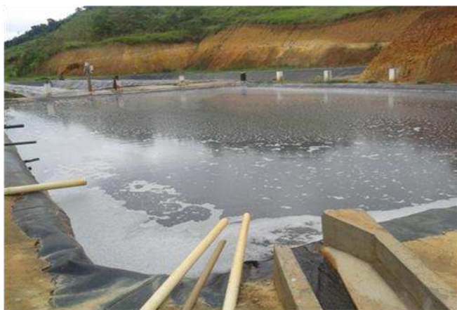
Lagoa de lixiviado bruto
