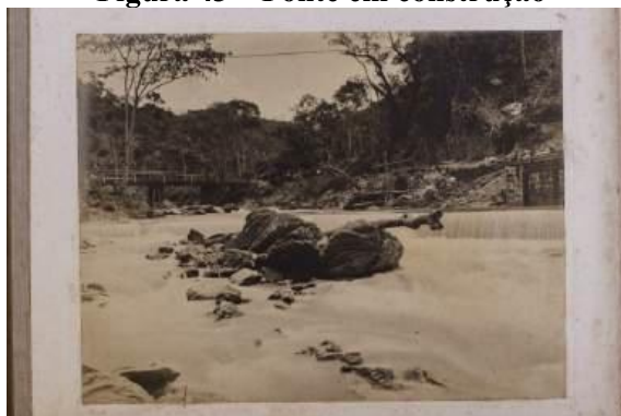
Figura 43 – Ponte em construção
