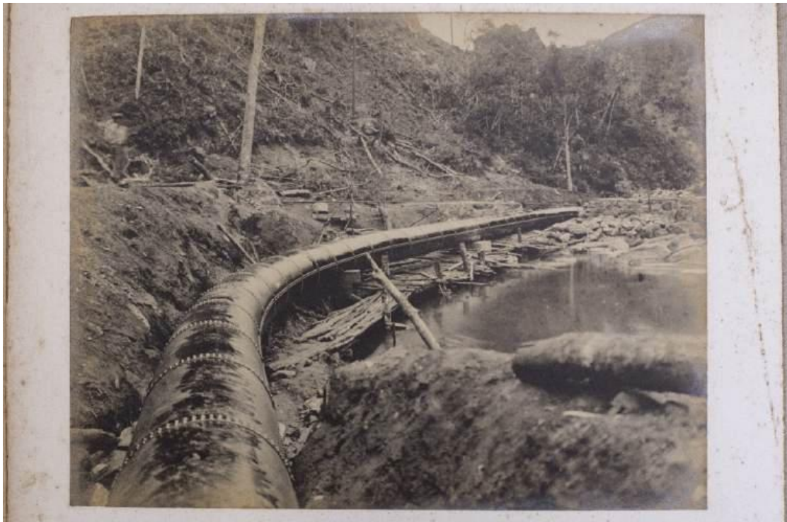
Figura 39 – Tubulação e árvores derrubadas
