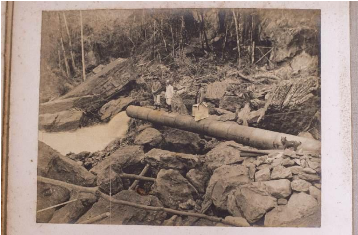
Figura 45 – Chalmers acompanhando a construção de uma tubulação
