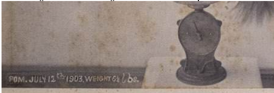
Figura 13 - Detalhe da figura 11 - foto do cão sendo pesado
