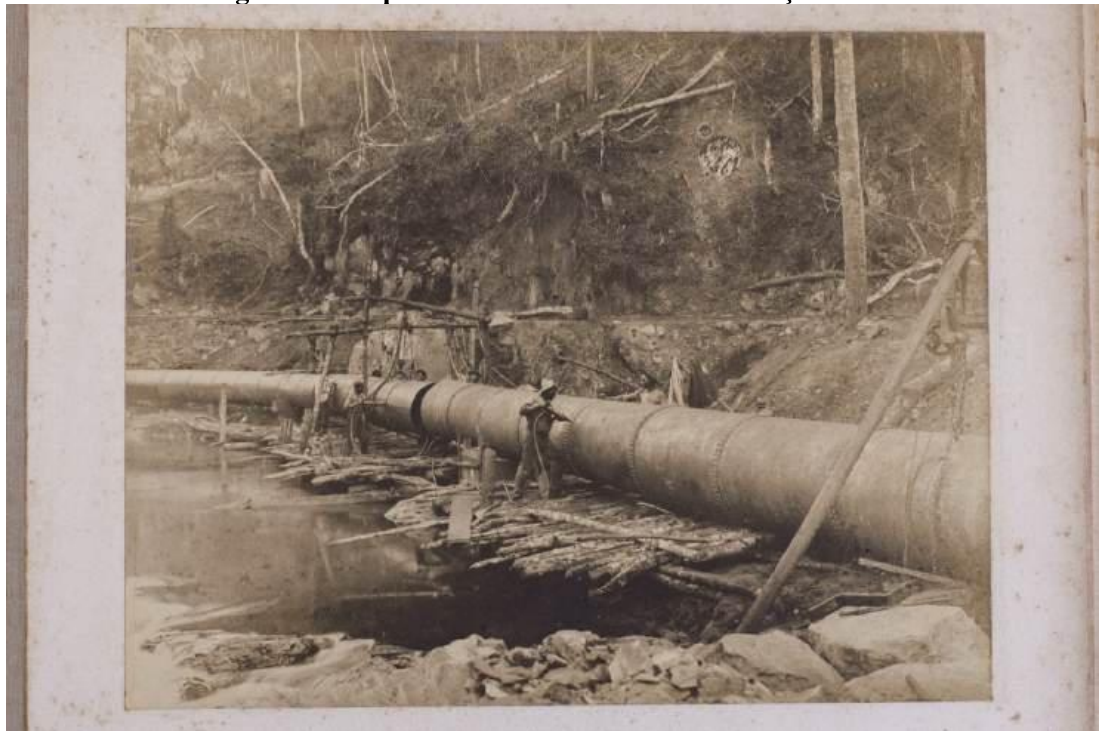
Figura 41 – Operários trabalhando em tubulação
