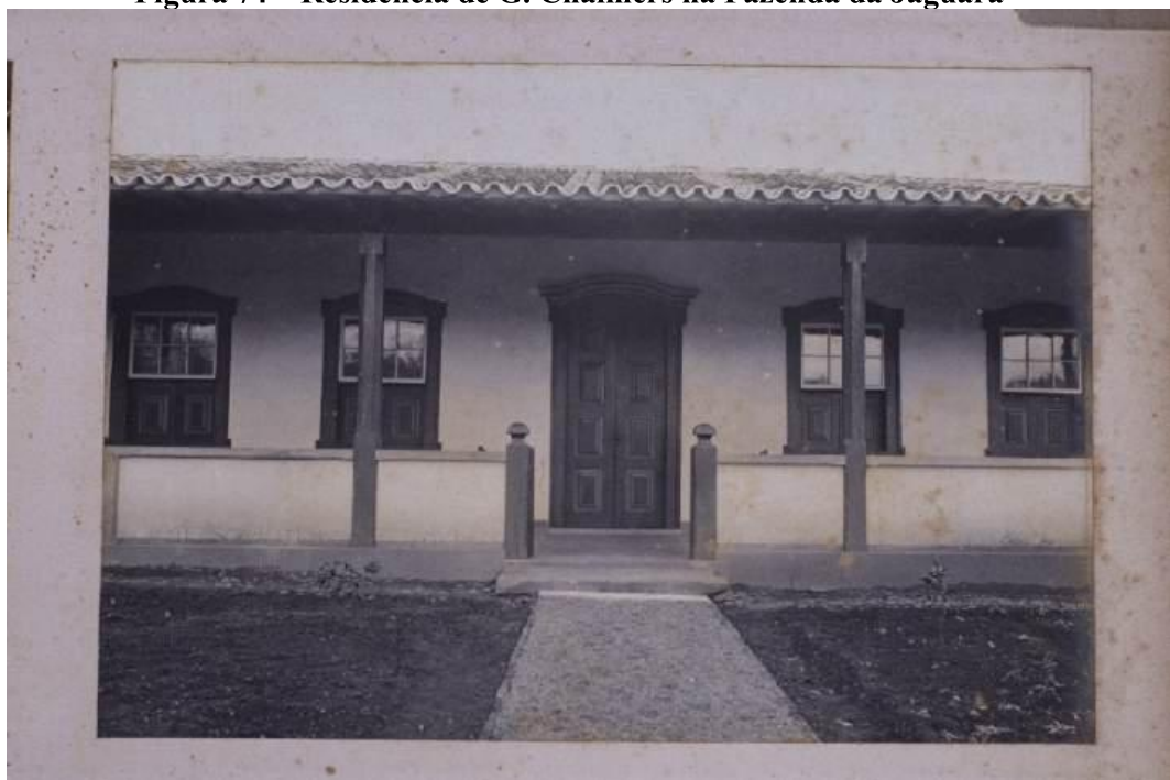
Figura 74 – Residência de G. Chalmers na Fazenda da Jaguará
