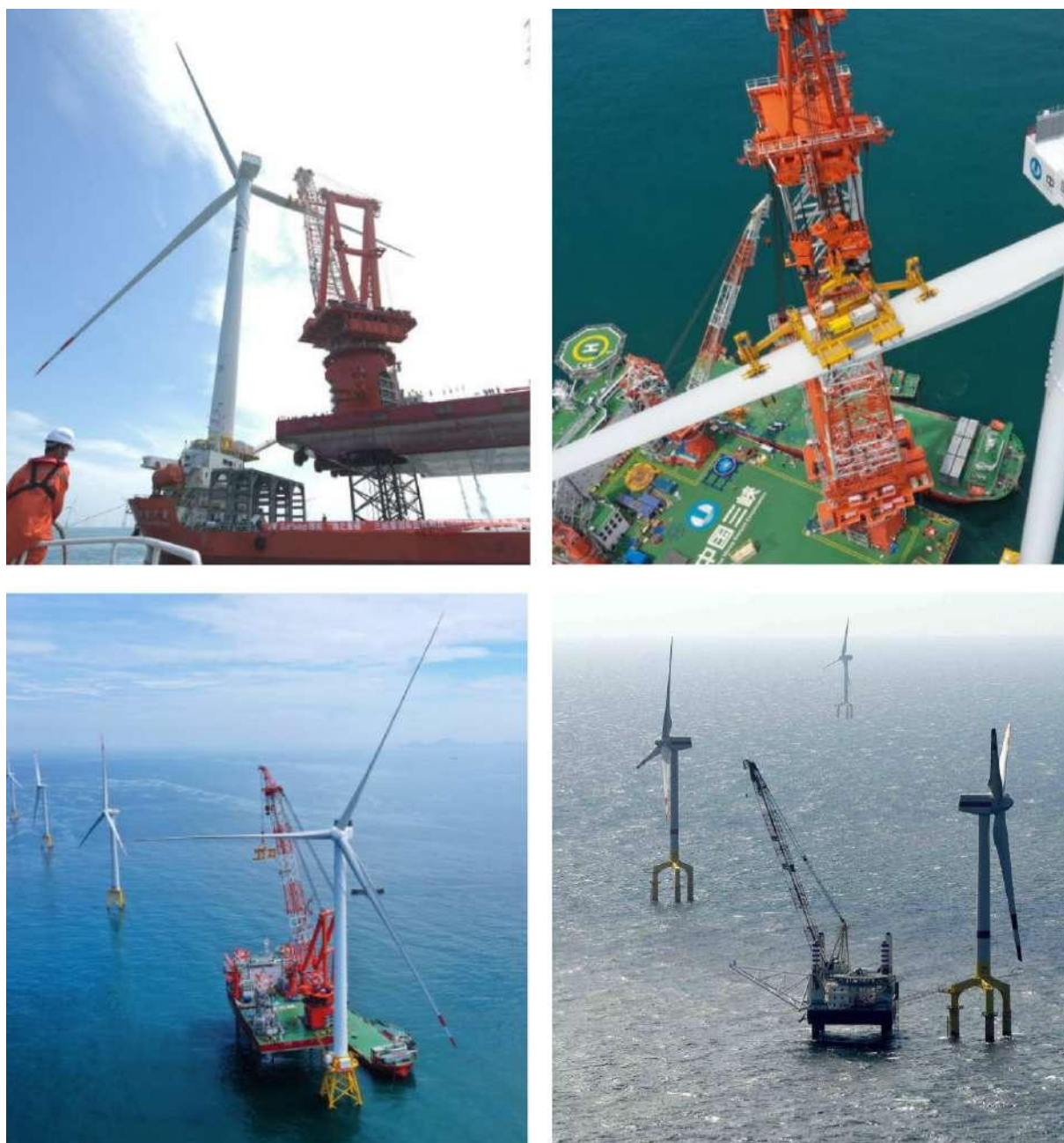
Figura 78 – Instalação do parque eólico de Fujian (Sudeste da China) com uma turbina de 16 MW.
