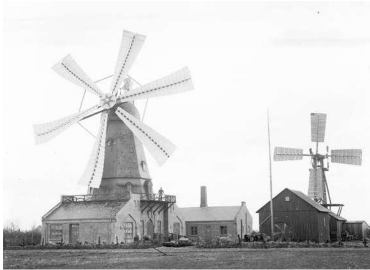
(b) Fotografia do galpão de la Cour.
