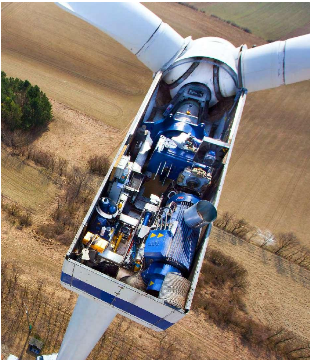
Figura 80 – Nacele aberta de uma turbina eólica.
