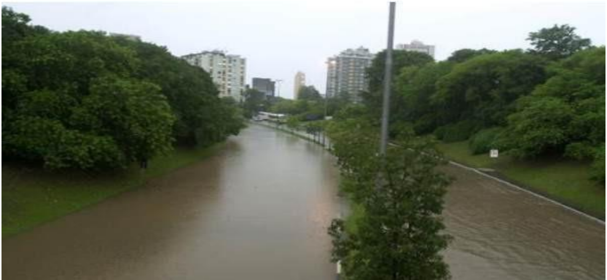
Figura 6 — Avenida Goethe antes da implementação do Plano diretor de Drenagem urbana
