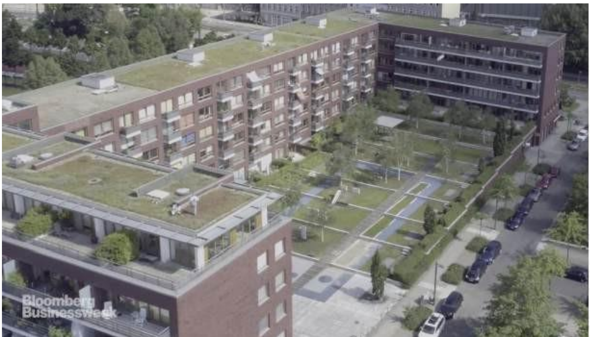
Figura 5 — Edifício com implementação de telhado verde em Berlim
