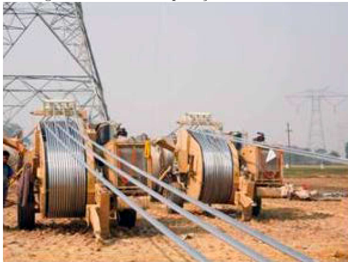
Figura 10: Fotografia mostrando operação de tensionamento dos cabos
