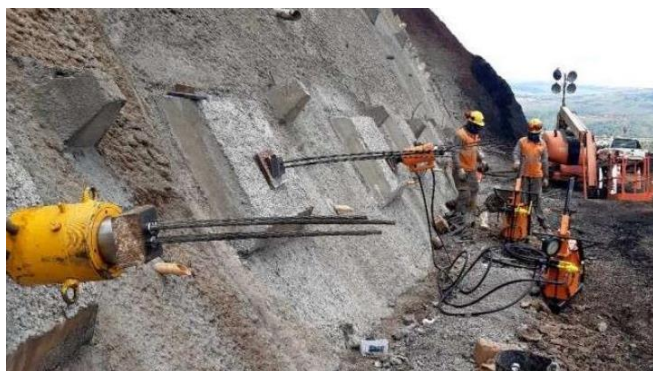
Figura 16 - Protensão de tirantes em cordoalhas
