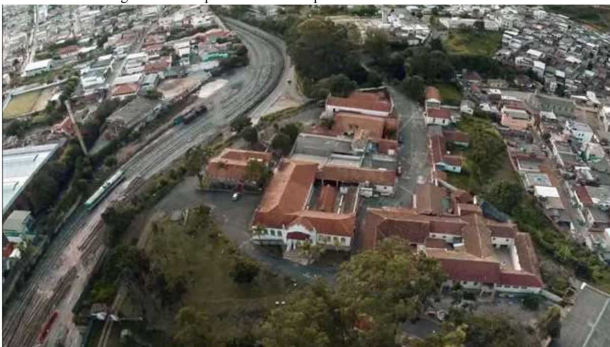
Figura 5 - Vista panorâmica do Departamento A – Assistência
