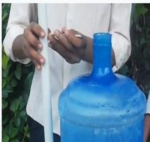
Construção mini biodigestor
