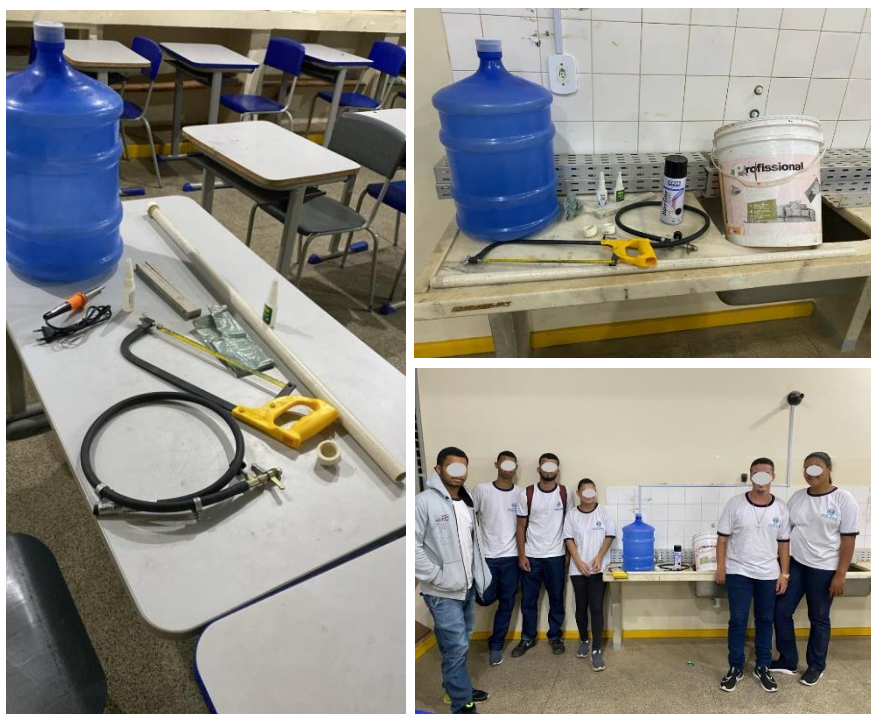
Figura 07 – Separação dos materiais para a construção do mini biodigestor
