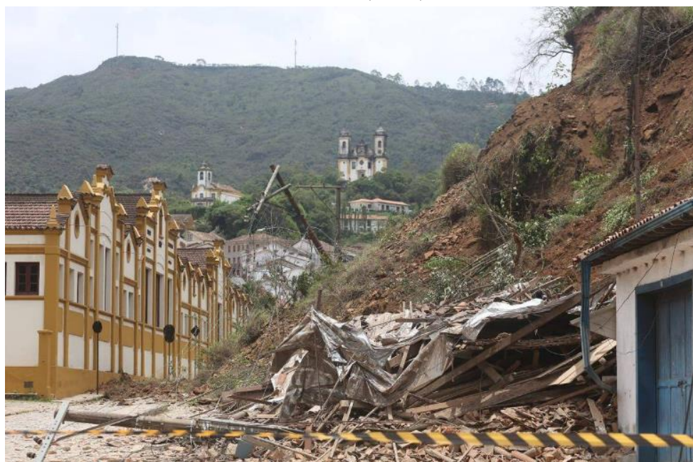
Figura 25 – Desmoronamento do Morro da Forca em Ouro Preto destruindo o casarão Solar Baeta Neves, 13/01/2022 (Foto 1).
