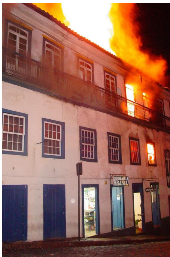
Figura 16 – Foto 2 do Incêndio no Hotel Pilão 14 de abril de 2003.
