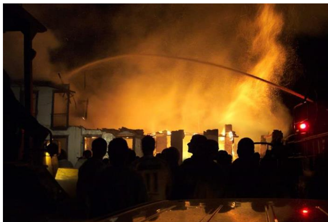
Figura 19 – Foto 5 do Incêndio no Hotel Pilão 14 de abril de 2003.
