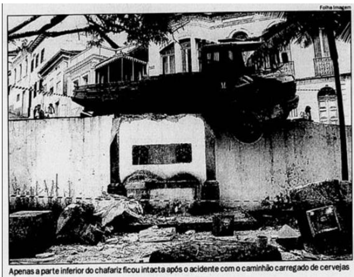
Figura 14 – Caminhão atinge o Chafariz da Igreja do Pilar (2002).
