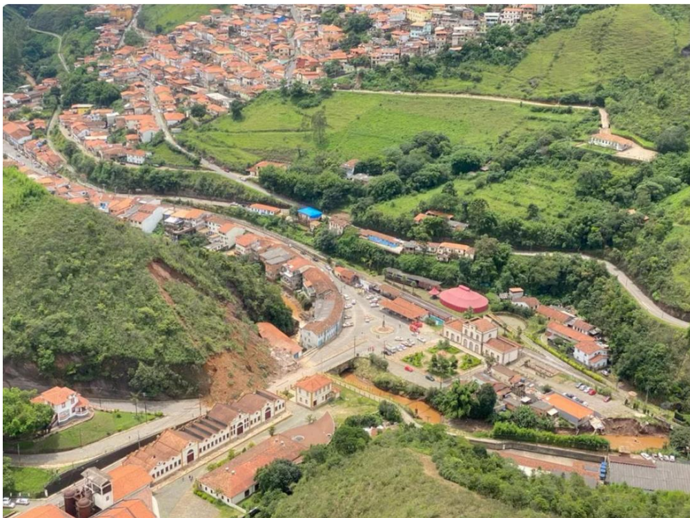
Figura 26 – Desmoronamento do Morro da Forca em Ouro Preto destruindo o casarão Solar Baeta Neves, 13/01/2022 (Foto 2).
