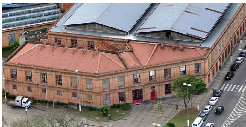
Figura 53 – Vista aérea do prédio da Secretaria de Educação, no complexo da antiga Companhia Têxtil Bernardo Mascarenhas (2020).
