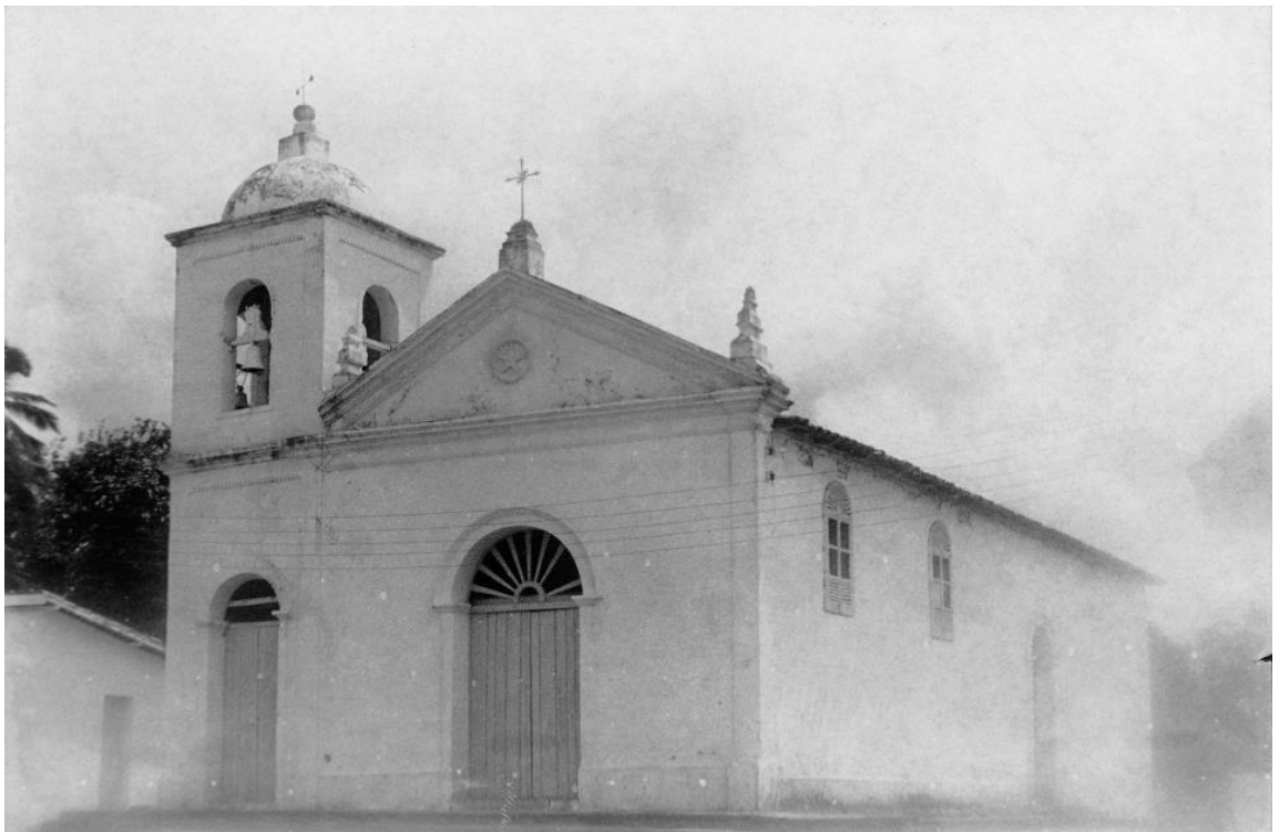
Imagem 6 – A antiga fachada da igreja
