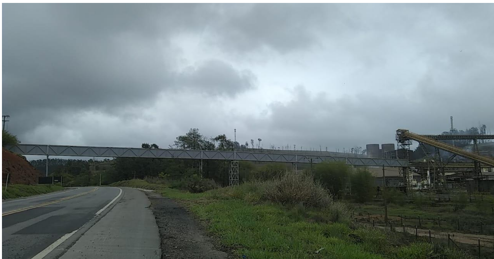
Figura 5 - Duto de rejeitos industriais da Nexa em Juiz de Fora/MG
