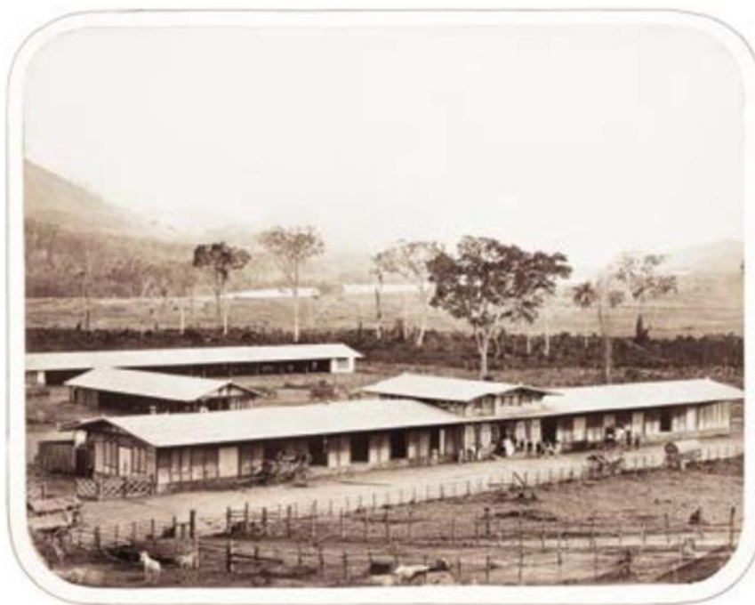
Figura 4 - Estação de Entre-Rios.
