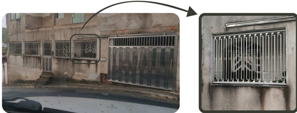
Figura (28) - Grade em aparas de aço inoxidável em Timóteo
