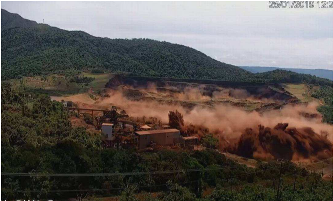
Figura (5) - Rompimento da barragem de Bento Rodrigues.
