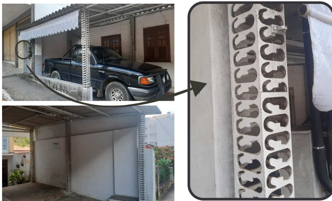
Figura (31) - Uso estrutural de aparas de chapas.
