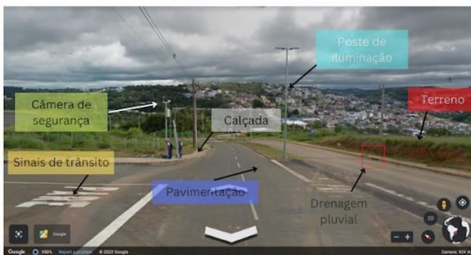
Figura 37. Foto do terreno, com intervenção do autor, 2022.
