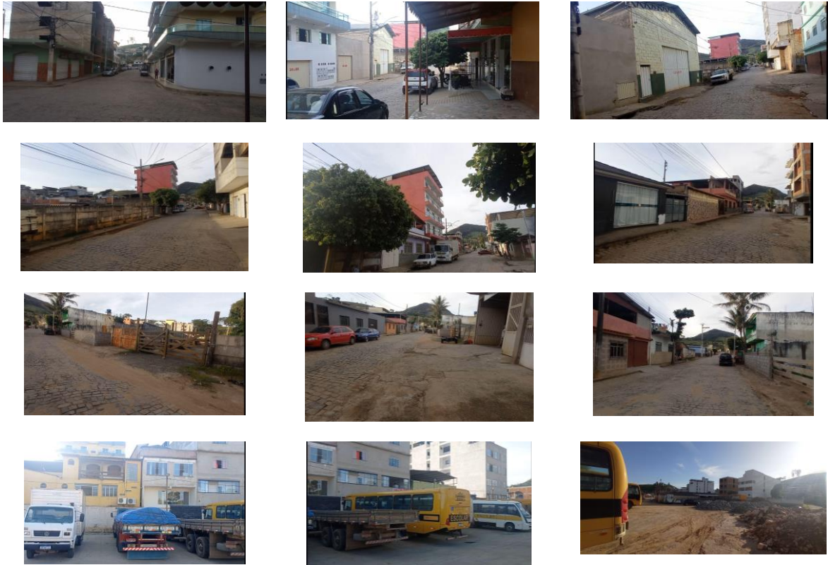
Quadro 3.1 - Fotografias realizadas dos edifícios adjacentes ao sítio
