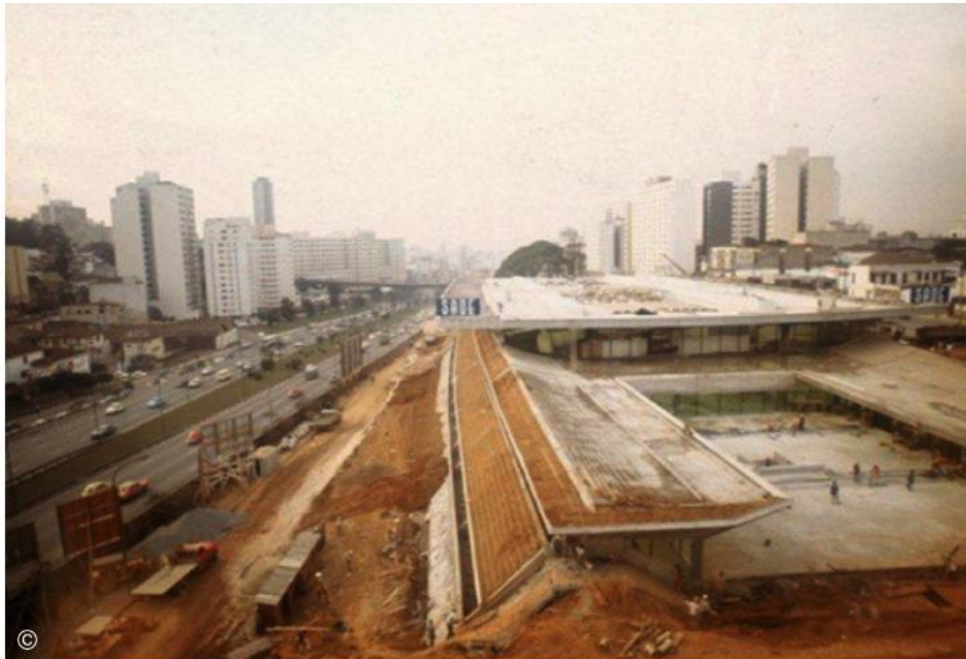
Figura 4.2 - Construção do Centro Cultural São Paulo
