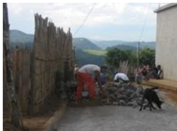
Foto 09 - Obras de pavimentação
