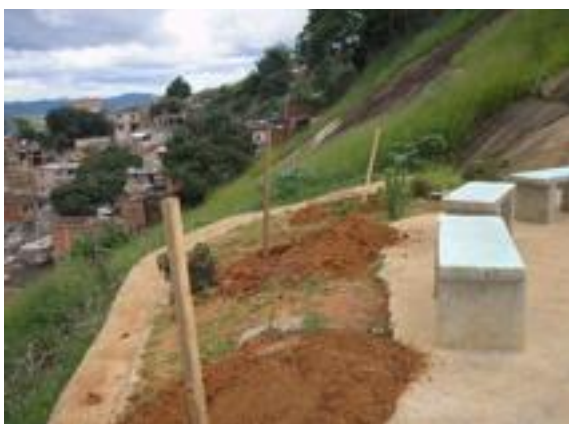
Foto 08 - Obras de contenção
