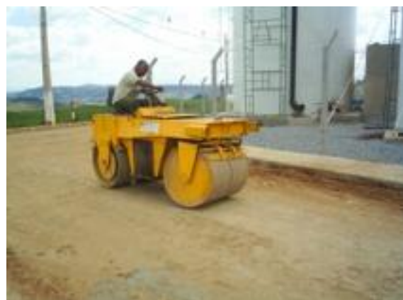
Foto 05 - Compactação e rolagem do pavimento - Rua dos Vencedores
