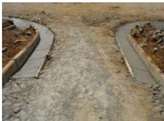
Foto 11 - Pavimentação de ruas e passeios
