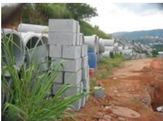
Foto 06 - Tubulação de drenagem de águas pluviais
