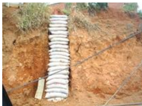
Foto 07 - Contenção do reaterro (linha de esgoto)
