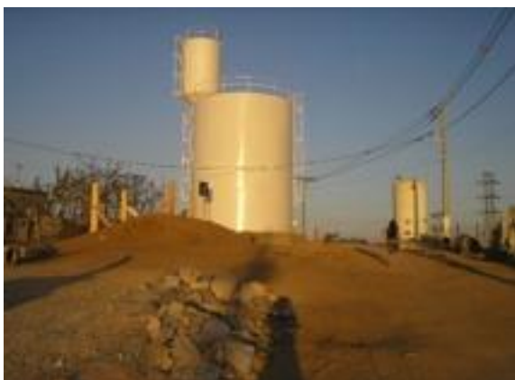
Foto 10 - Centro de reservação
