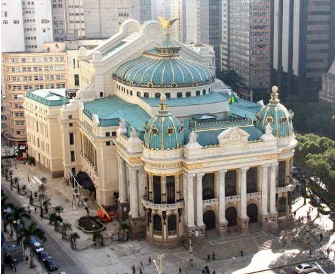
Figura 33: Theatro Municipal do Rio de Janeiro atualmente.
