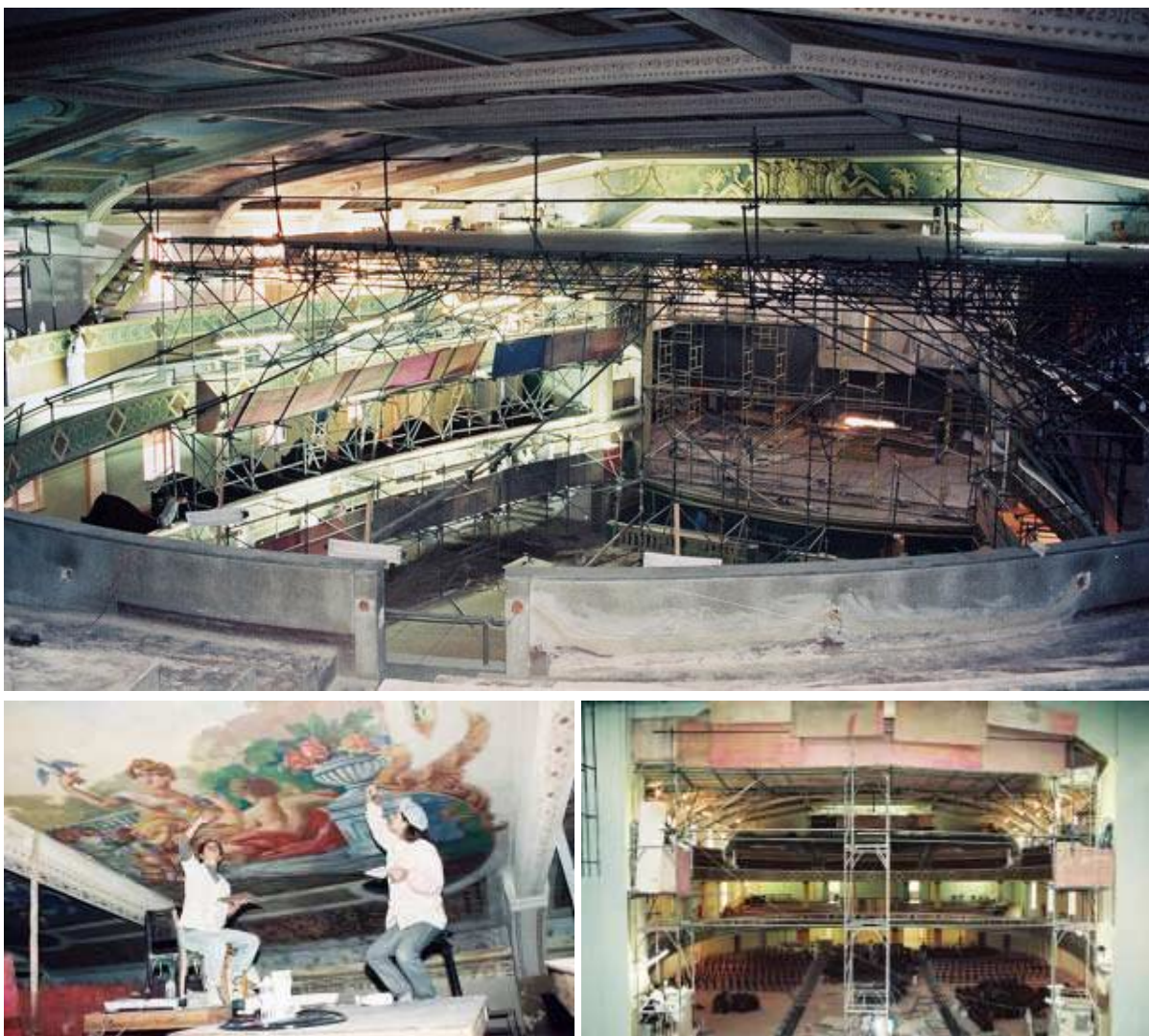
Figura 50: Restauração do Cine-Theatro Central, 1996.
