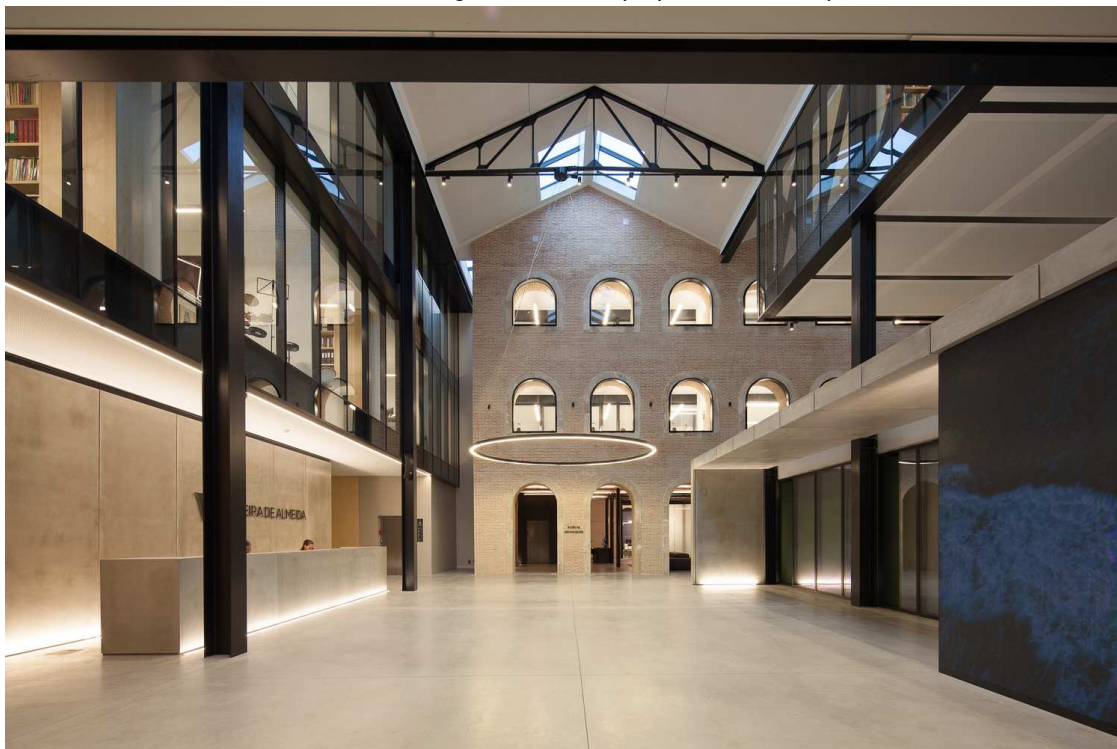
Figura 11: Interior do escritório com estrutura original mantida e proposta de novos pavimentos com estrutura metálica.
