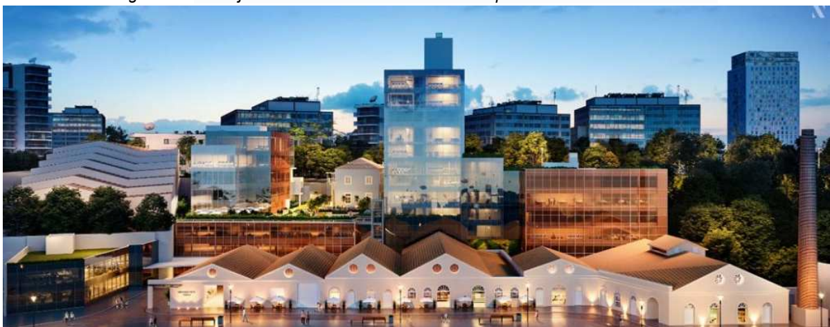
Figura 25: O conjunto do centro Executivo Carl Hoepcke e o armazém Rita Maria.
