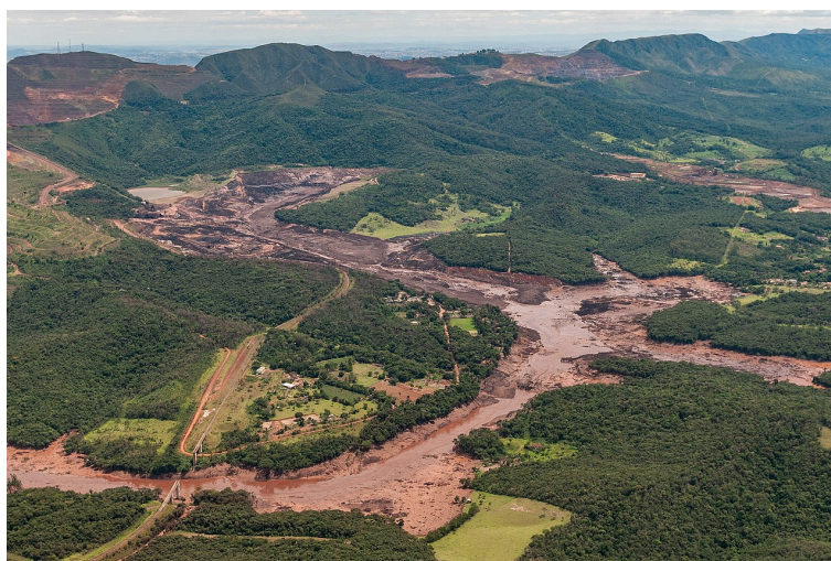
Figura 2 – Vista da destruição deixada pelo rompimento da barragem de Brumadinho-MG.
