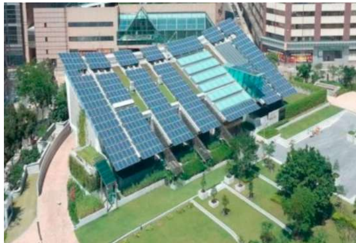
Figura 2.3: Edifício localizado em Hong Kong utilizado como estudo de caso por Li, Wang e Cheung (2018).
