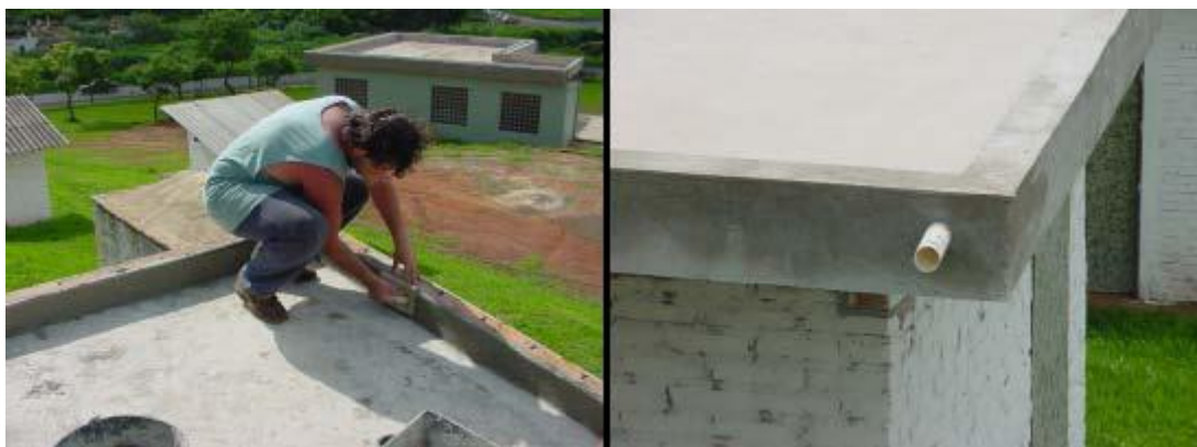
Figura 20 - Execução das platibandas e colocação dos tubos para drenagem e captação da água. Fonte: Lima (2004).
