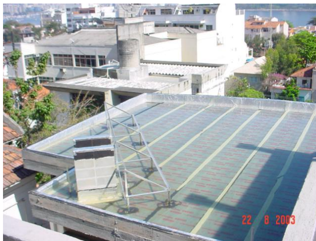
Figura 41 - Teste de estanqueidade para melhor garantia do sistema. Fonte: Lichtenberg (2006).
