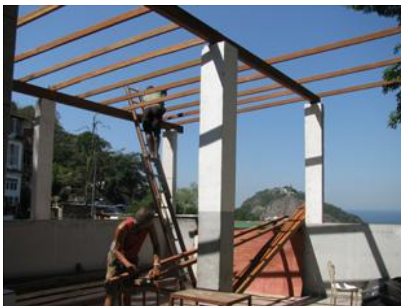
Figura 11 - Estrutura de madeira sendo montada para receber a base de suporte. Fonte:< www.tibarose.com/port/projetos-babilonia.php >. Acesso em: 23/04/2012.
