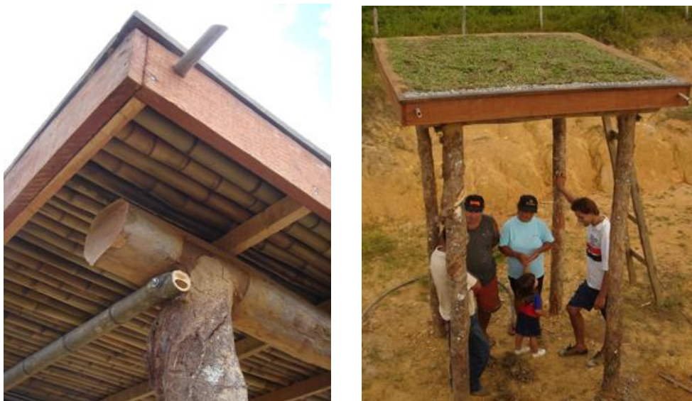
Figura 17: Bambu mirim, canela, maçaranduba e jacaré: todos os materiais do local e tubos de saída de drenagem no projeto em Santa Maria, SP.
