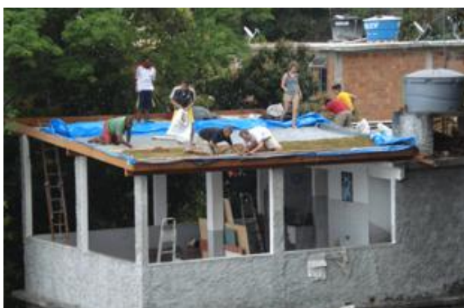
Figura 13- Execução das várias camadas simultaneamente.
