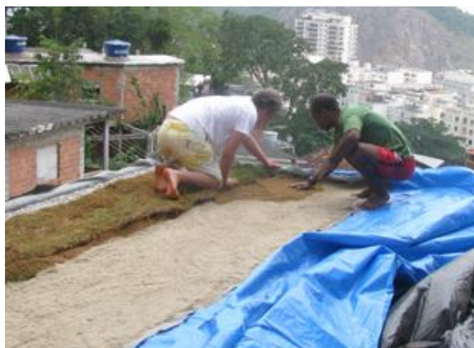
Figura 14 - Camada de areia sendo aplicada sobre o geotêxtil e a lona de impermeabilização. Aplicação da terra e grama. Fonte:< www.tibarose.com/port/projetos-babilonia >.php. Acesso em: 23/04/2012.
