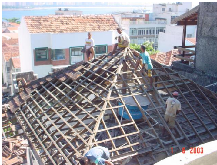
Figura 37- Madeiramento sendo retirado do antigo telhado depois do destelhamento.
