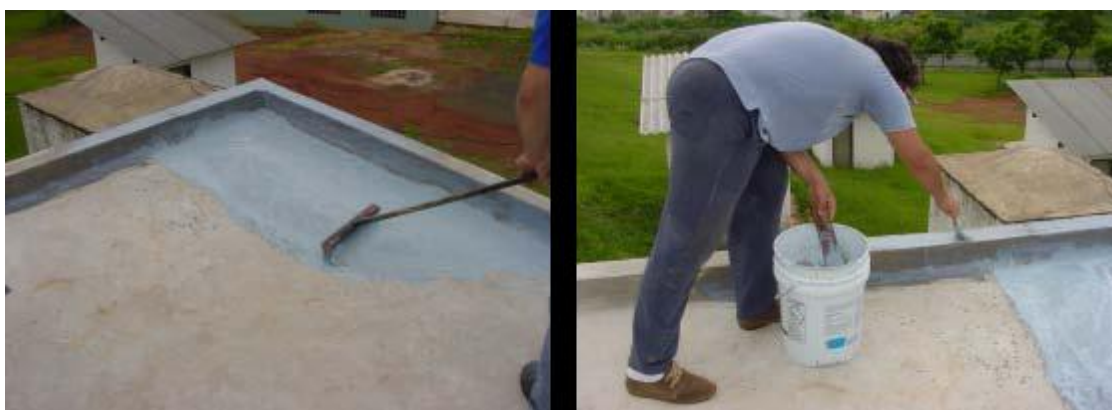
Figura 21- Aplicação da nata de cimento com látex na laje e na platibanda Fonte: Lima (2004).
