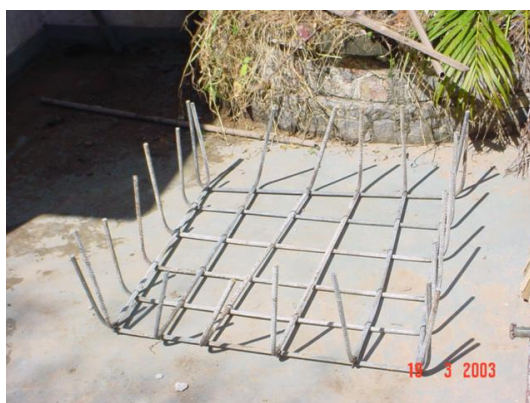
Figura 39 - Aço utilizado para armação das sapatas dos pilares novos de ferro. Fonte: Lichtenberg (2006).
