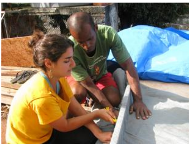
Figura 12- Retirada do excesso do geotêxtil deixando sobra para fixação do sistema.
