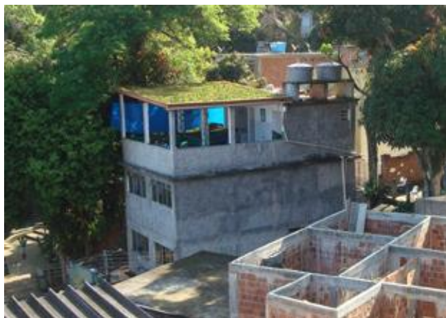
Figura 16- Cobertura verde concluída.
