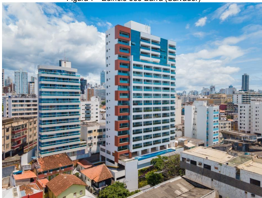
Figura 7 - Edifício 535 Barra (Salvador)
