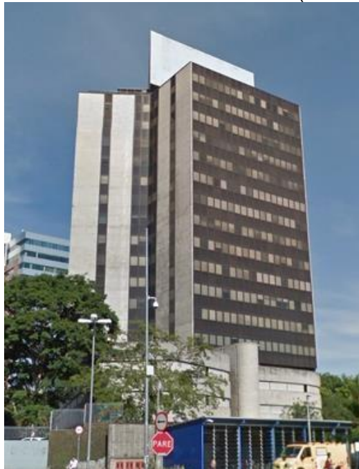
Figura 4 - Edifício Passarelli São Paulo (São Paulo)
