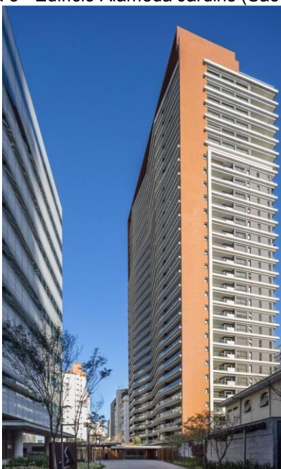
Figura 5 - Edifício Alameda Jardins (São Paulo)
