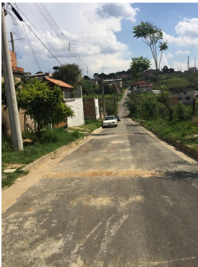
Imagem 11 – Vista da rua 02 do bairro Cidade Nova após execução das obras de esgotamento no bairro (11/11/2019)
