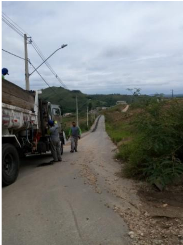
Imagem 10 - Obra de esgotamento no bairro Cidade Nova – 29/10/2018
