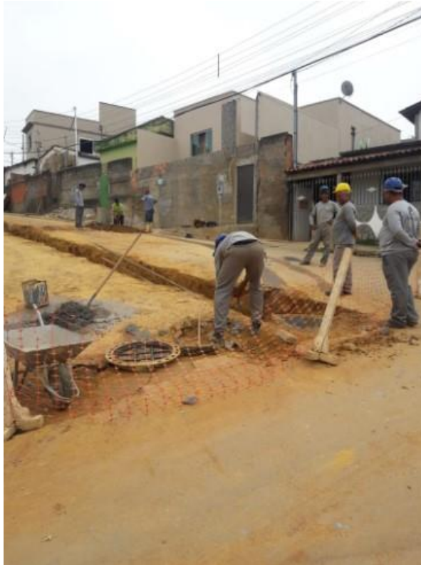
Imagem 9 - Obra de esgotamento no bairro São Dimas – 15/10/2018
