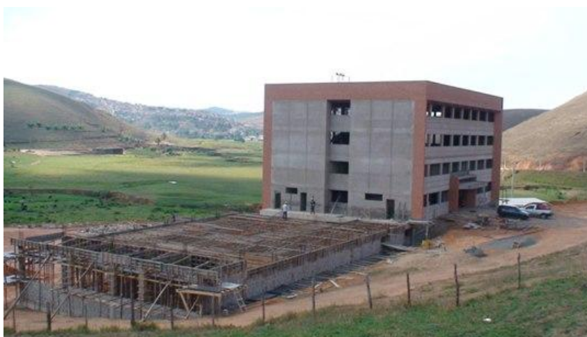
Figura 33: Obras do Hospital Escola da Univértix
