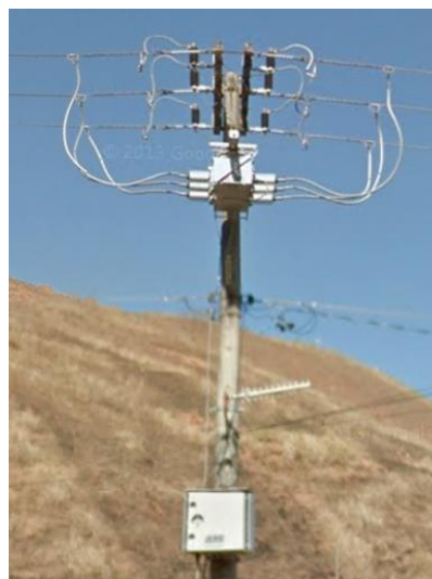
Figura 2-41 – Chave telecomandada (Equipamento homologado na Cemig)
