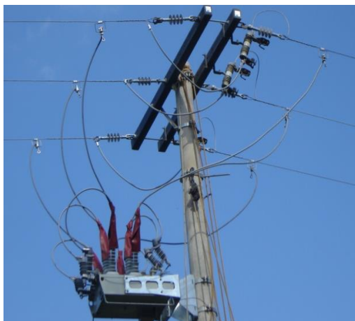
Figura 2-40 – Modelos de religadores instalados no sistema de energia elétrica (Equipamento homologado na Cemig)
