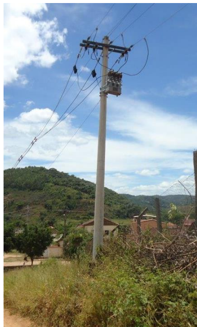
Figura 2-34 – Conjunto de medição instalado na rede (Equipamento homologado na Cemig)
