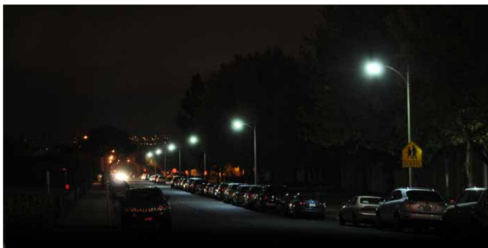
Figura 19 – Rua iluminada com lâmpadas HPMV
