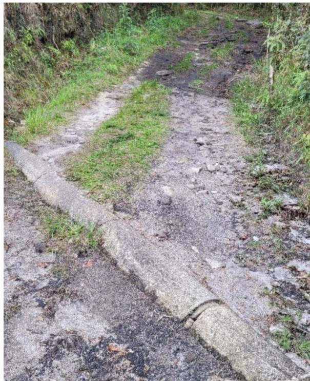
Figura 16 – Intervenção de Drenagem no Parque Estadual do Ibitipoca.
