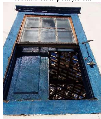
Figura 44 – Detalhe do telhado visto pela janela
