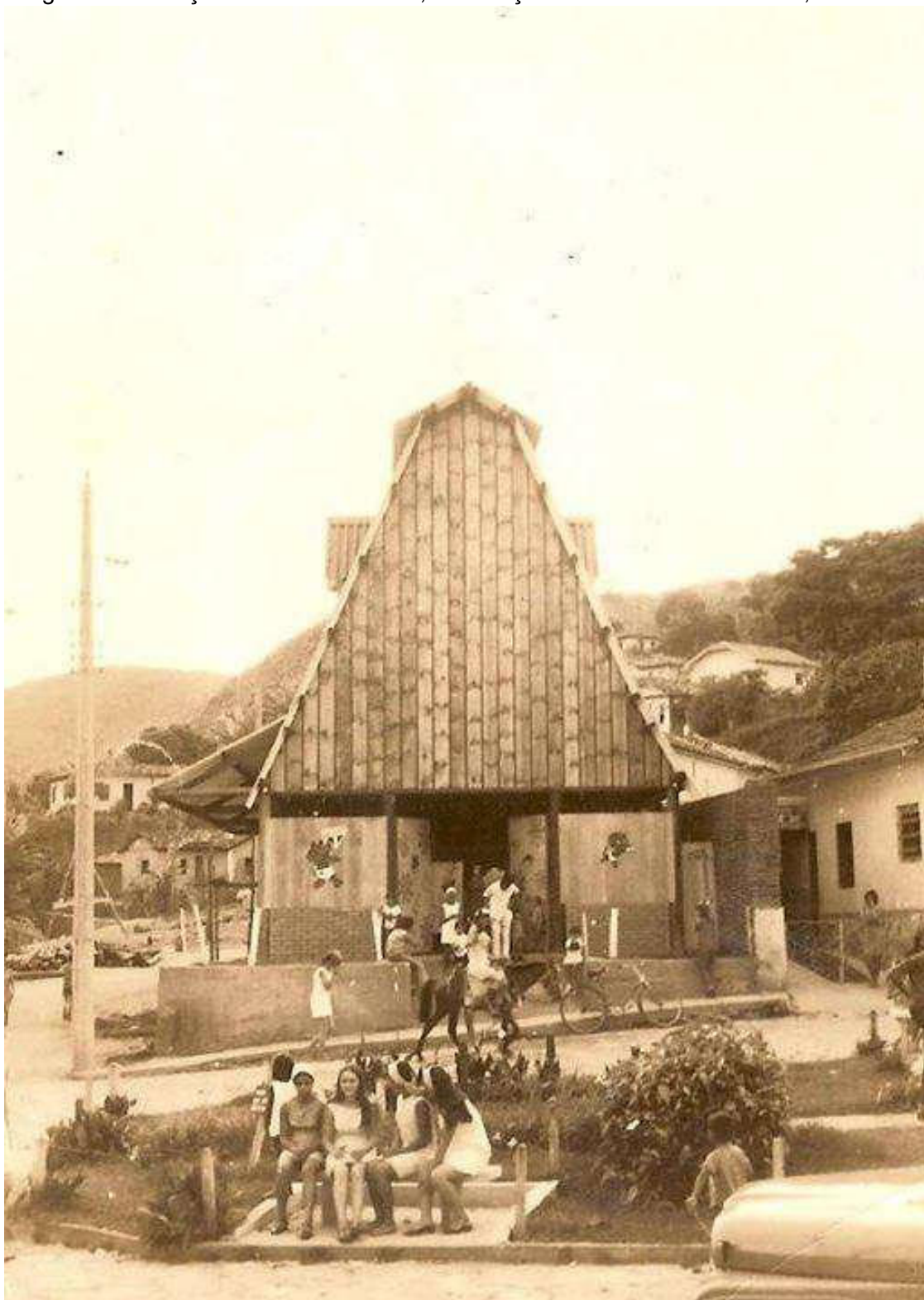
Figura 62 – Praça Dr. Viviano Caldas, construção da sede do Clube UCA, em 1969
