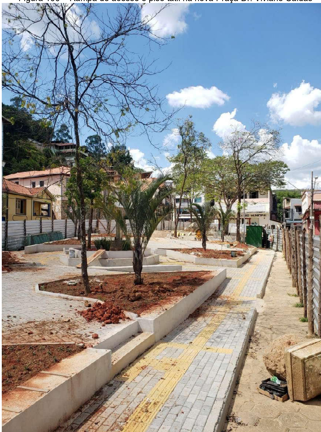
Figura 100 – Rampa de acesso e piso tátil na nova Praça Dr. Viviano Caldas
