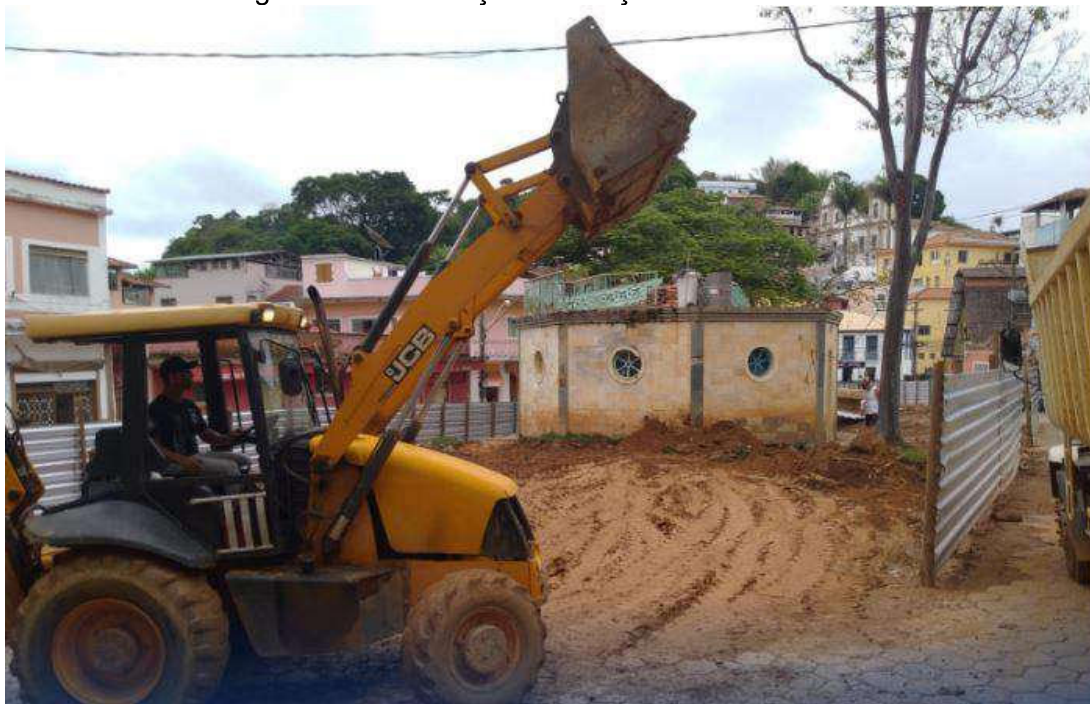
Figura 96 – Demolição da Praça Dr. Viviano Caldas
