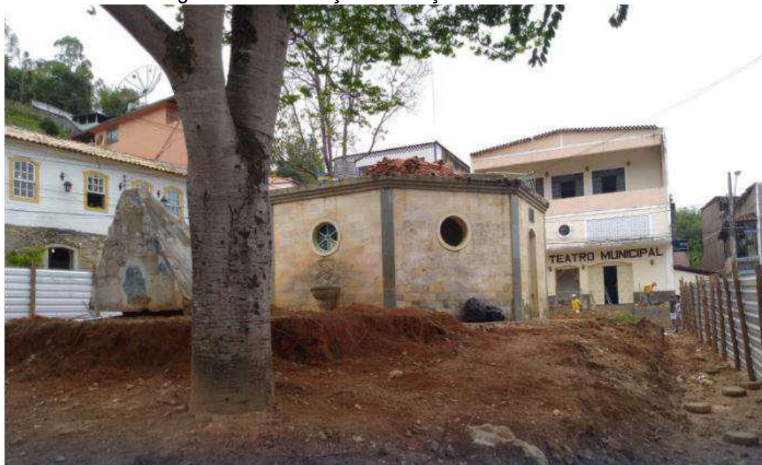
Figura 97 – Demolição da Praça Dr. Viviano Caldas
