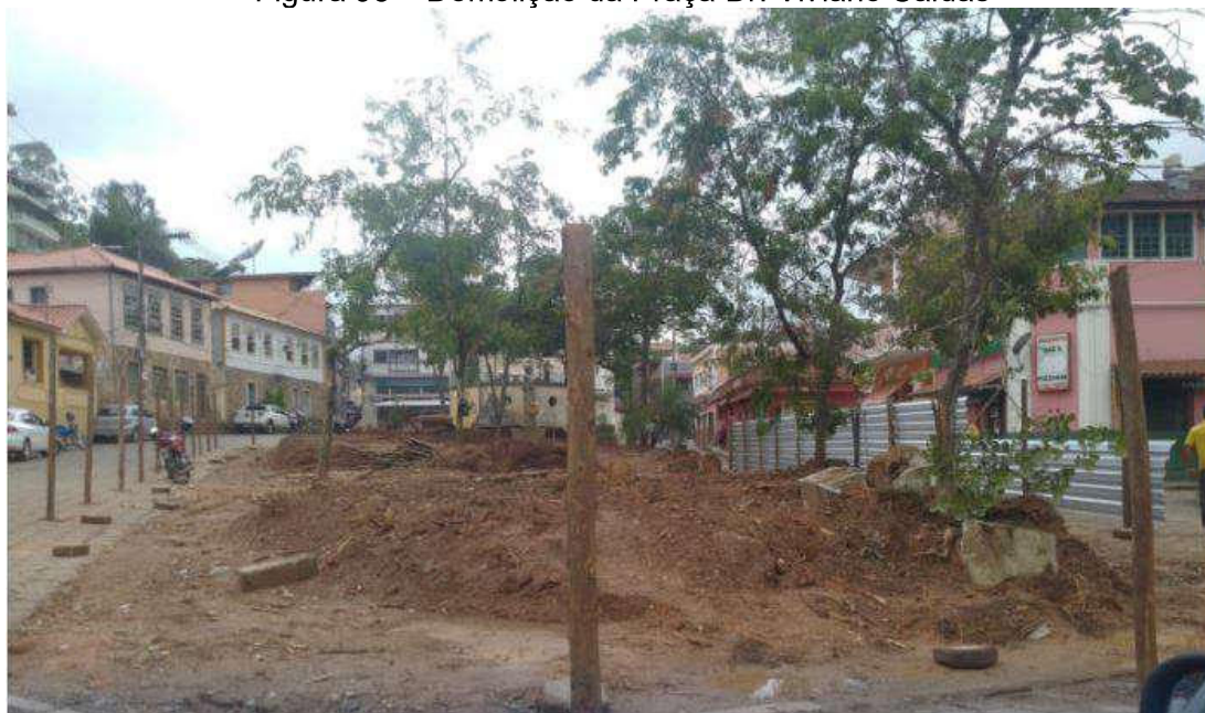
Figura 95 – Demolição da Praça Dr. Viviano Caldas
