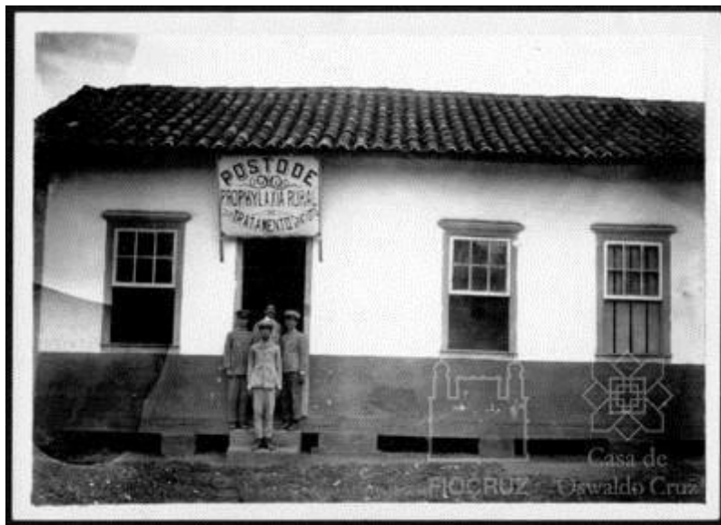
Figura 10 - Fachada do Sub-posto de São Sebastião da Estrela* (192-?)
