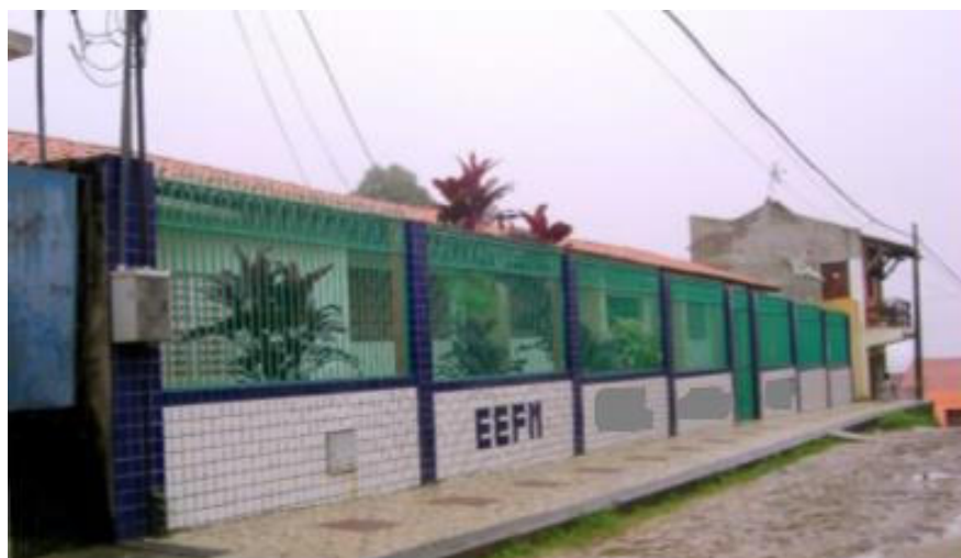
Figura 3 - Fachada da escola
