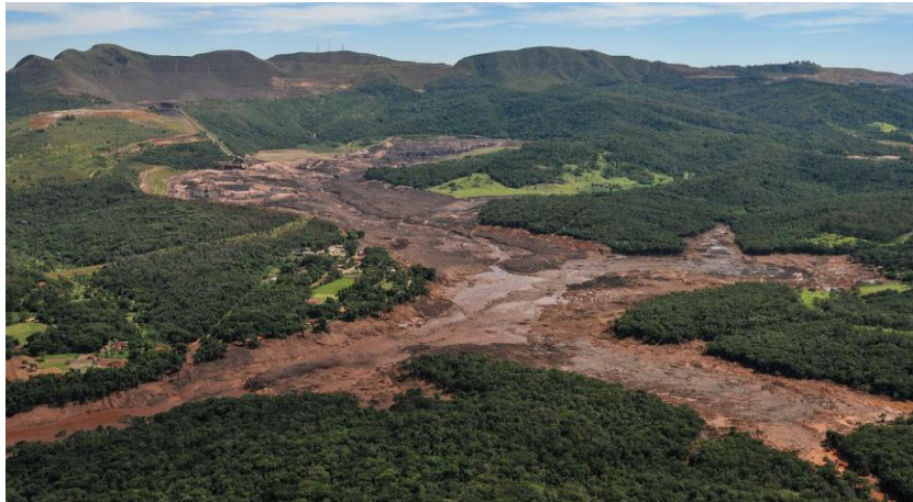
Figura 3: Rompimento de Barragem em Brumadinho-MG.
