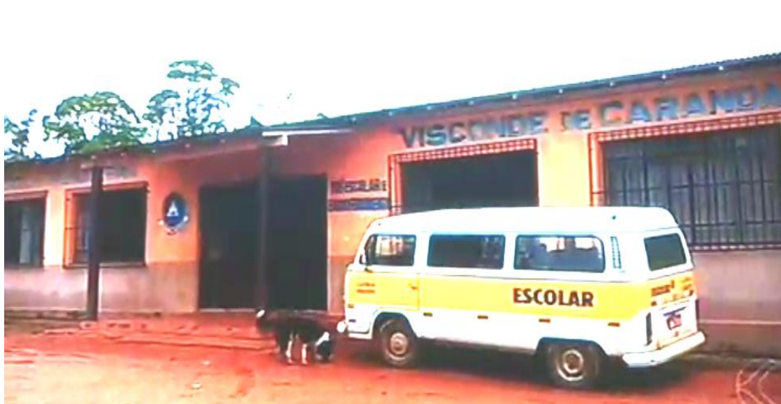
Figura 6 – Escola Municipal Visconde de Carandaí do Distrito de Ponto Chique do Martelo
